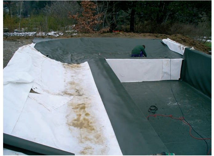
Pose de la bâche d'étanchéité.
