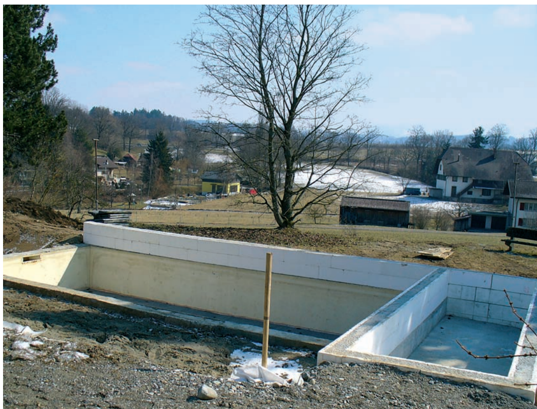
Des murets complémentaires ont été créés et le bassin rehaussé.
